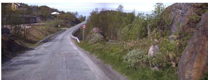
Rekkverksforlengelser og grøfting. Profil 6900
