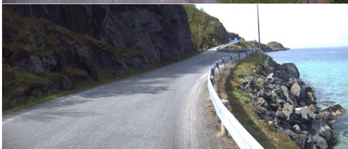
Vegbredder og møteplasser mellom Nikkelverket og Hamn turistanlegg.
