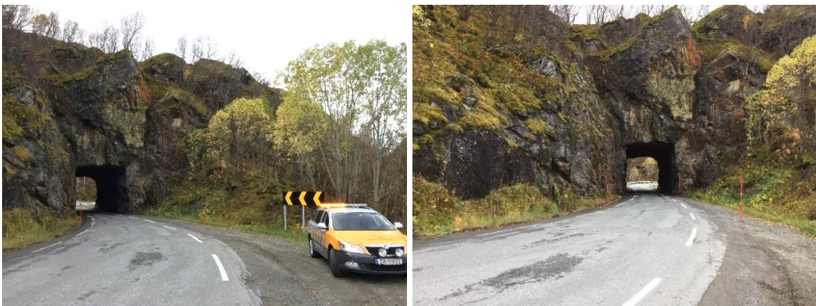
Figur 9 Knapp sving før tunnel gjennom Styrberget
