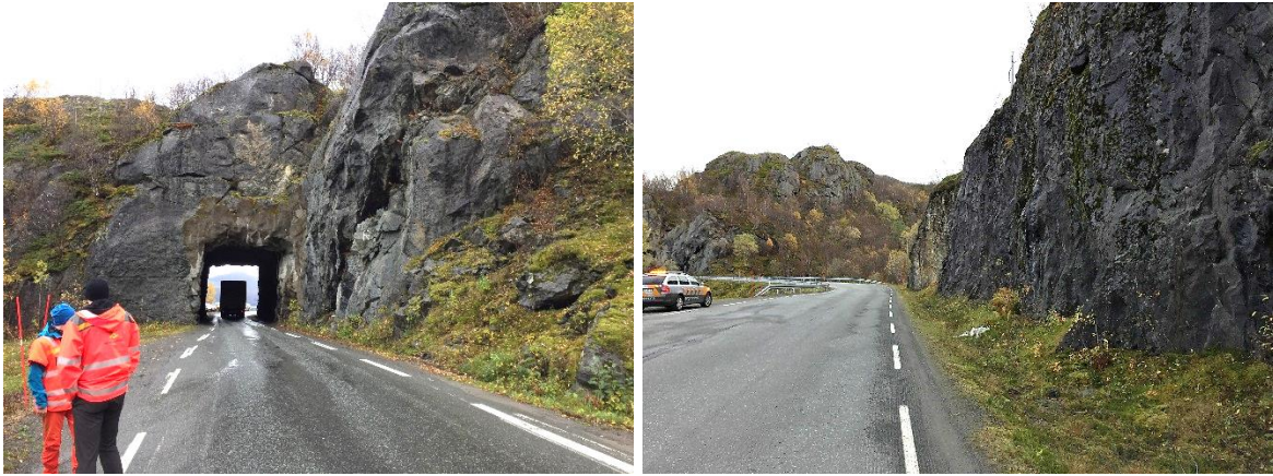
Figur 10 Tunnel gjennom Styrberget sett fra Styrbergvika og Styrbergvika
