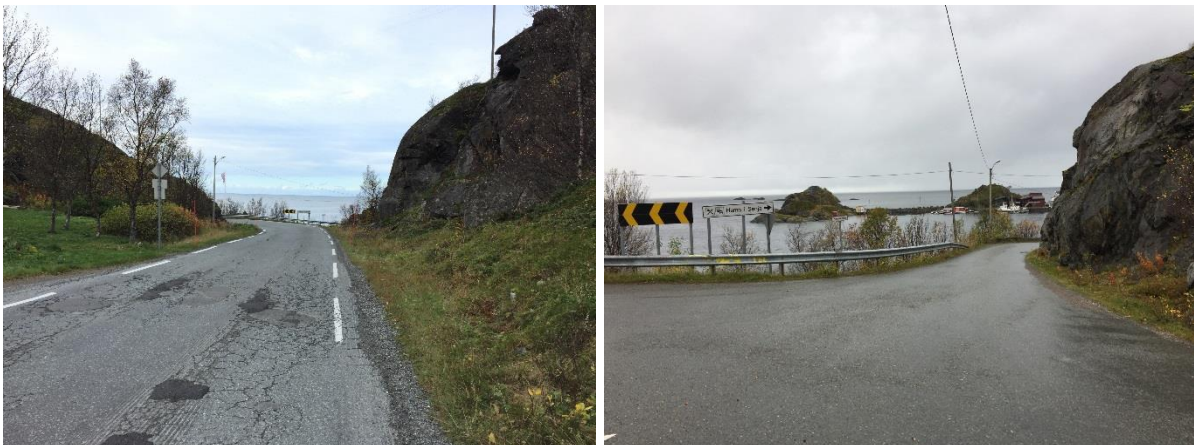
Figur 15 Rett før avkjøringa til Hamn og avkjøringa ned mot Hamn
